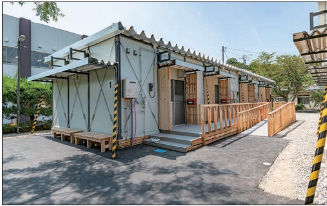
平成30年7月豪雨災害時に建設した応急仮設住宅
